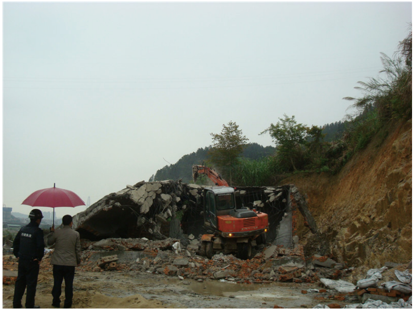
3月，区国土资源局配合亭江镇政府在东岐村拆除违法建设
