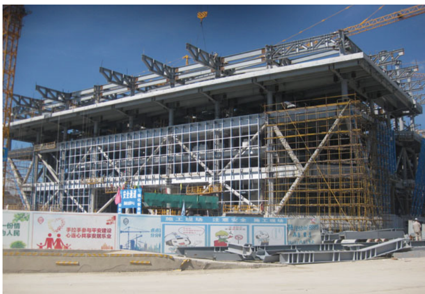
6 月，建设中的海峡青年交流营地主场馆
