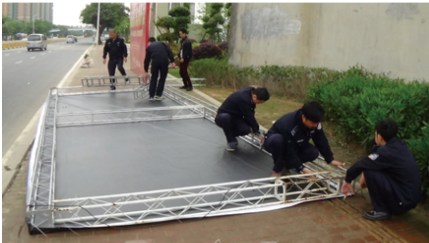
4月20日,马尾一中队在江滨东大道三环路口拆除违章设置大型广告牌
